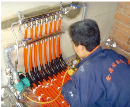
图1-9 | 打压测试
