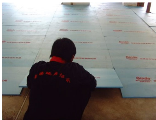
图1-7 | 铺设挤塑板
